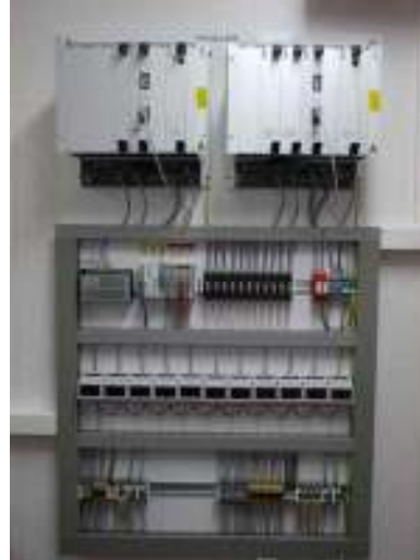
Kodery LEU i symulator sygnałów na semaforach
